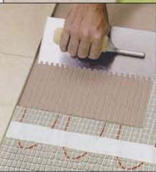
Beispiel Fliesenheizung: Die Heizkabel des frei verlegbaren Warmup-Systems werden einfach in den Fliesenkleber eingebettet (oben). Für größere Flächen empfiehlt sich das Mattensystem (kleines Foto).
