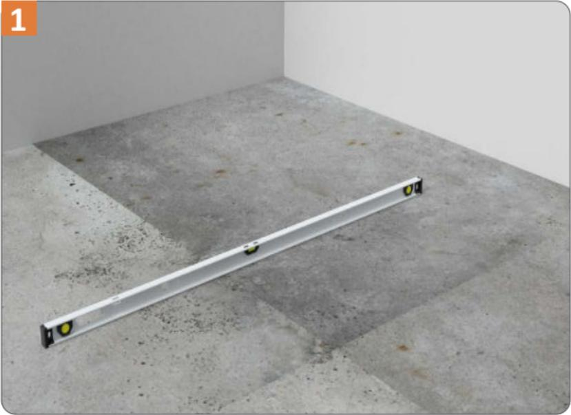
Der Untergrund muss ausgehärtet, sauber und trocken sein und falls erforderlich sollte eine passende Ausgleichsmasse aufgetragen werden, um eine glatte Oberfläche zu erhalten.
