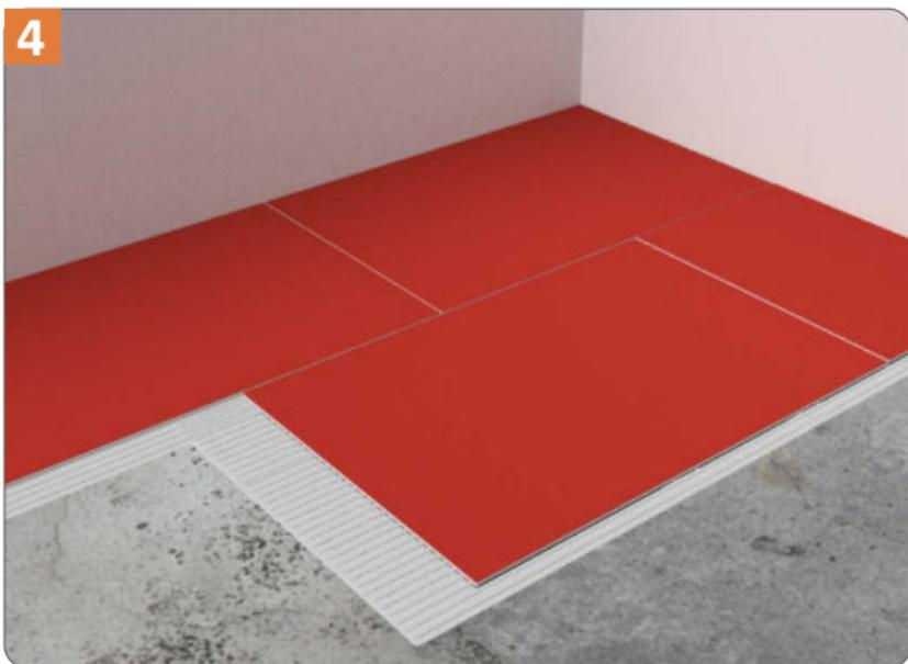
Die Ultralight muss auf ein frisch mit einem Zahnpachtel aufgetragenes Kleberbett gebettet und gründlich in das Bett eingedrückt werden, um sicherzustellen, dass unter den Platten keine Hohlräume verbleiben. Alle Platten müssen im Versatz verlegt werden.
