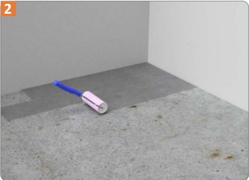
Den Untergrund mit einer verdünnten (1:4) SBR-Lösung grundieren. Bei speziellen Untergründen folgen Sie den Herstelleranweisungen.
