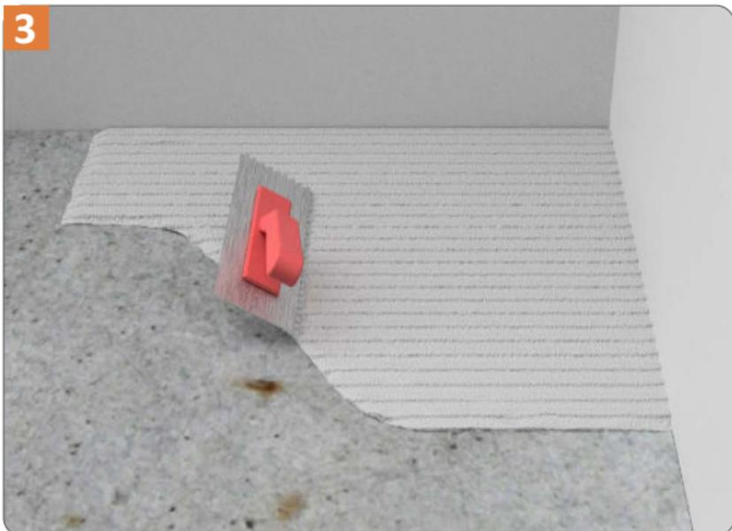
Die Warmup Ultralight sollte mit einem flexiblen, zementbasierten Kleber installiert werden. Der Kleber ist mit einem 6 mm x 6 mm ( $\frac{1}{4}$ " x  $\frac{1}{4}$ " ) Zahnpachtel aufzutragen und zu verteilen, um eine gleichmässige Kleberschicht zu gewährleisten.
